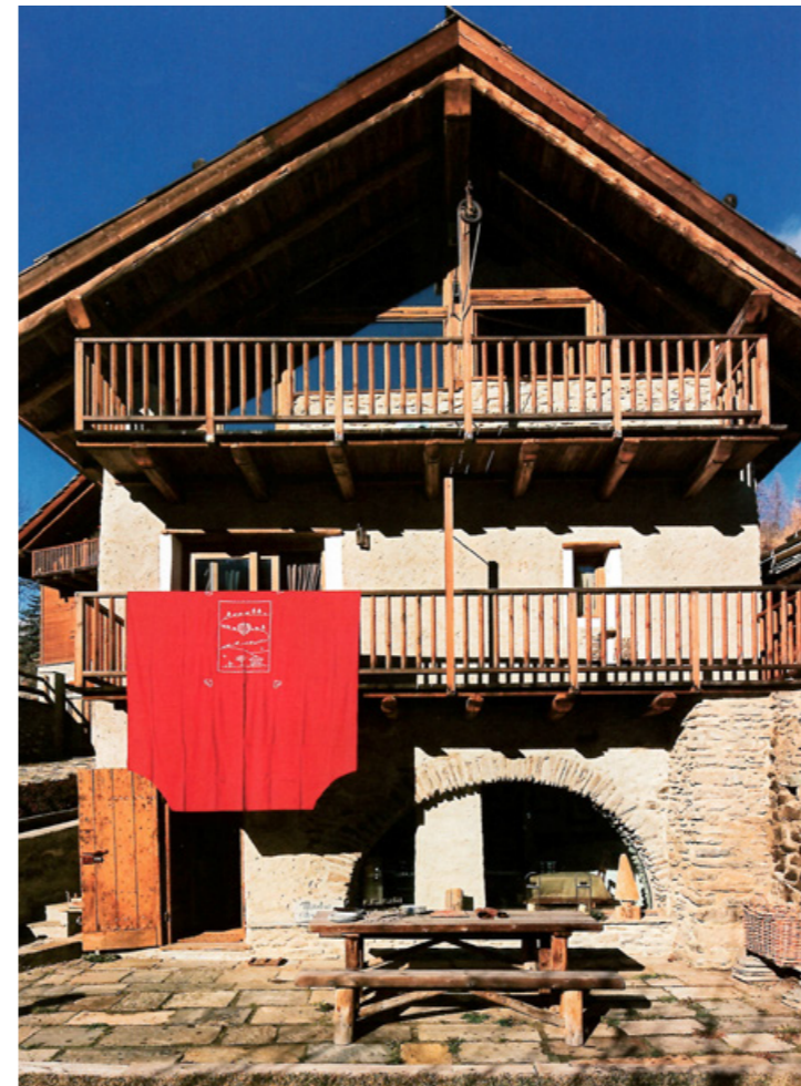
Casa V.N. - ristrutturazione - abitazione unifamiliare
