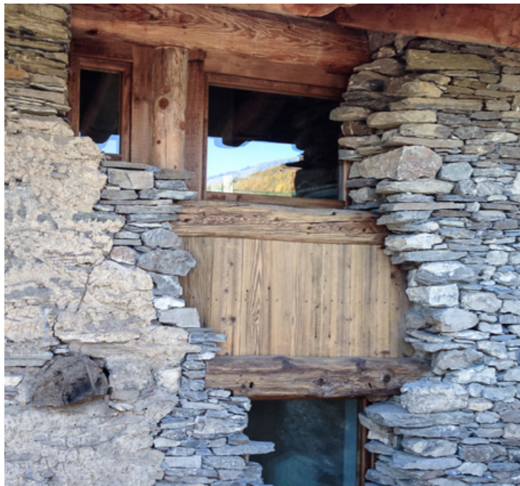
Casa F.K. - ristrutturazione - abitazione unifamiliare
