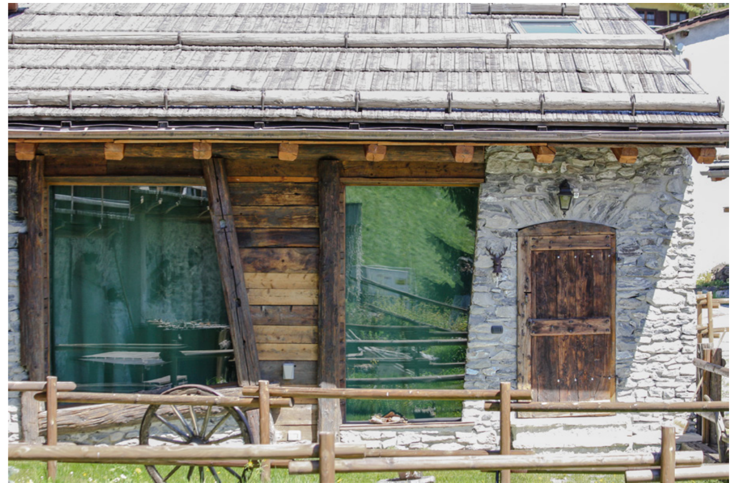
Lou Praije - ristrutturazione - abitazione plurifamiliare
