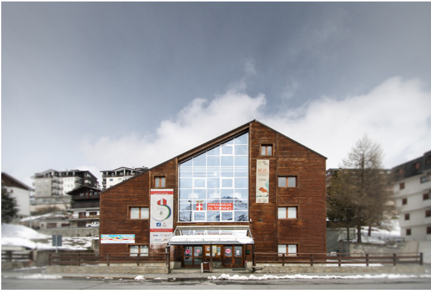
Casa Olimpia - nuova costruzione - centro culturale
