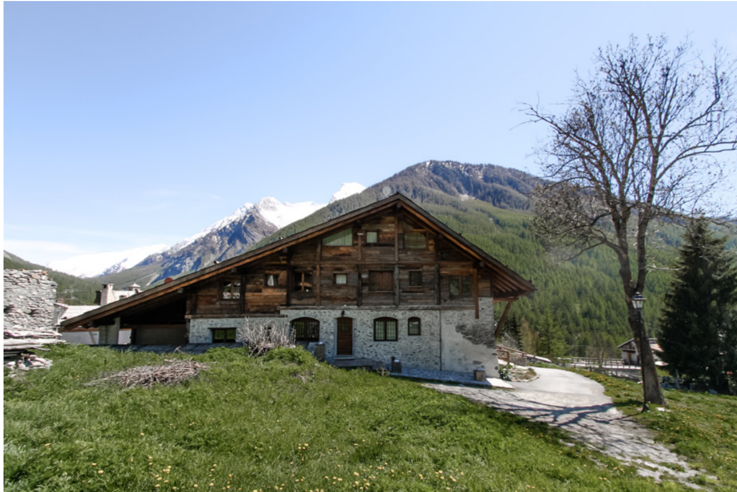
Lou Praije - ristrutturazione - abitazione plurifamiliare
