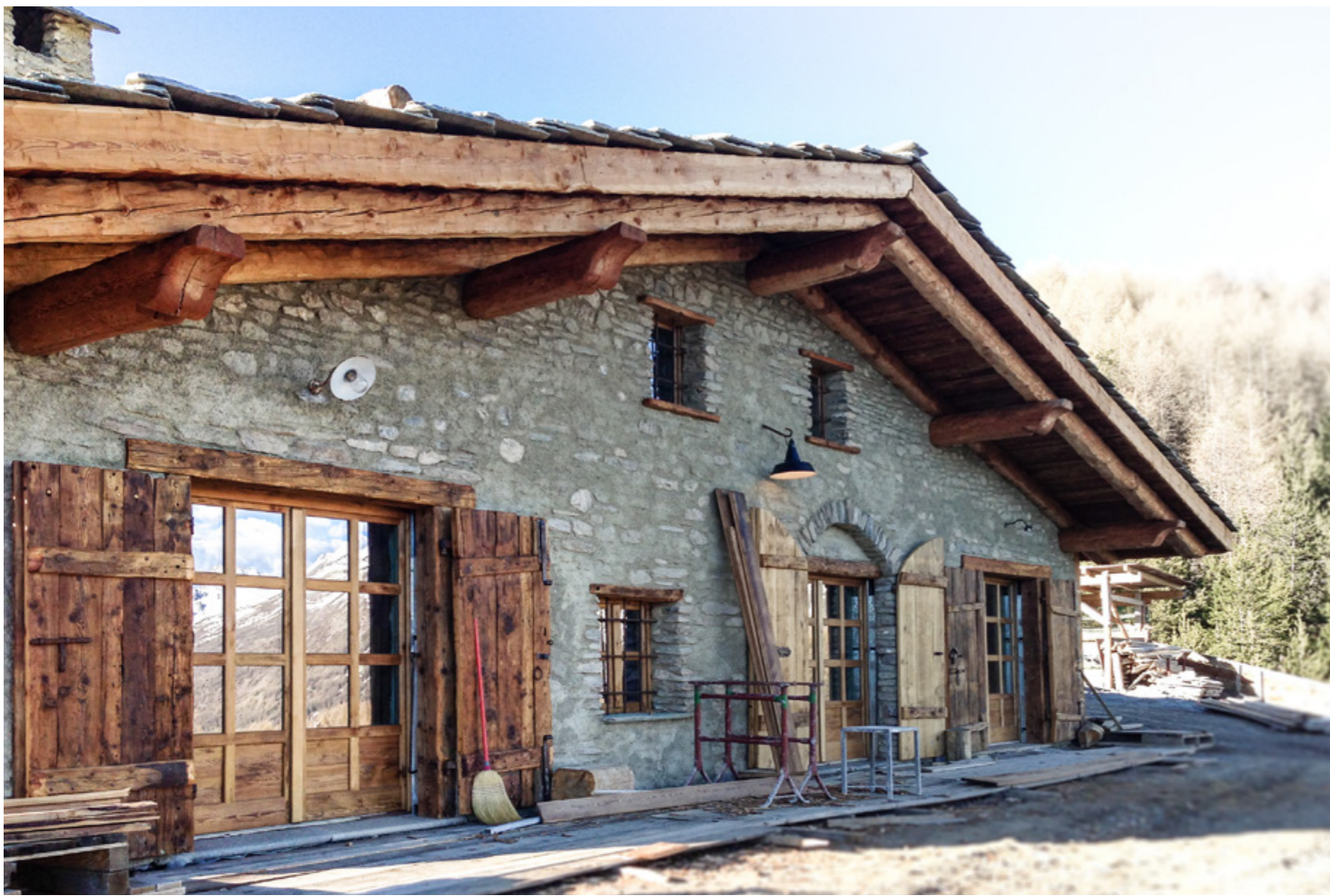
Casa G. B. - ristrutturazione - abitazione unifamiliare
