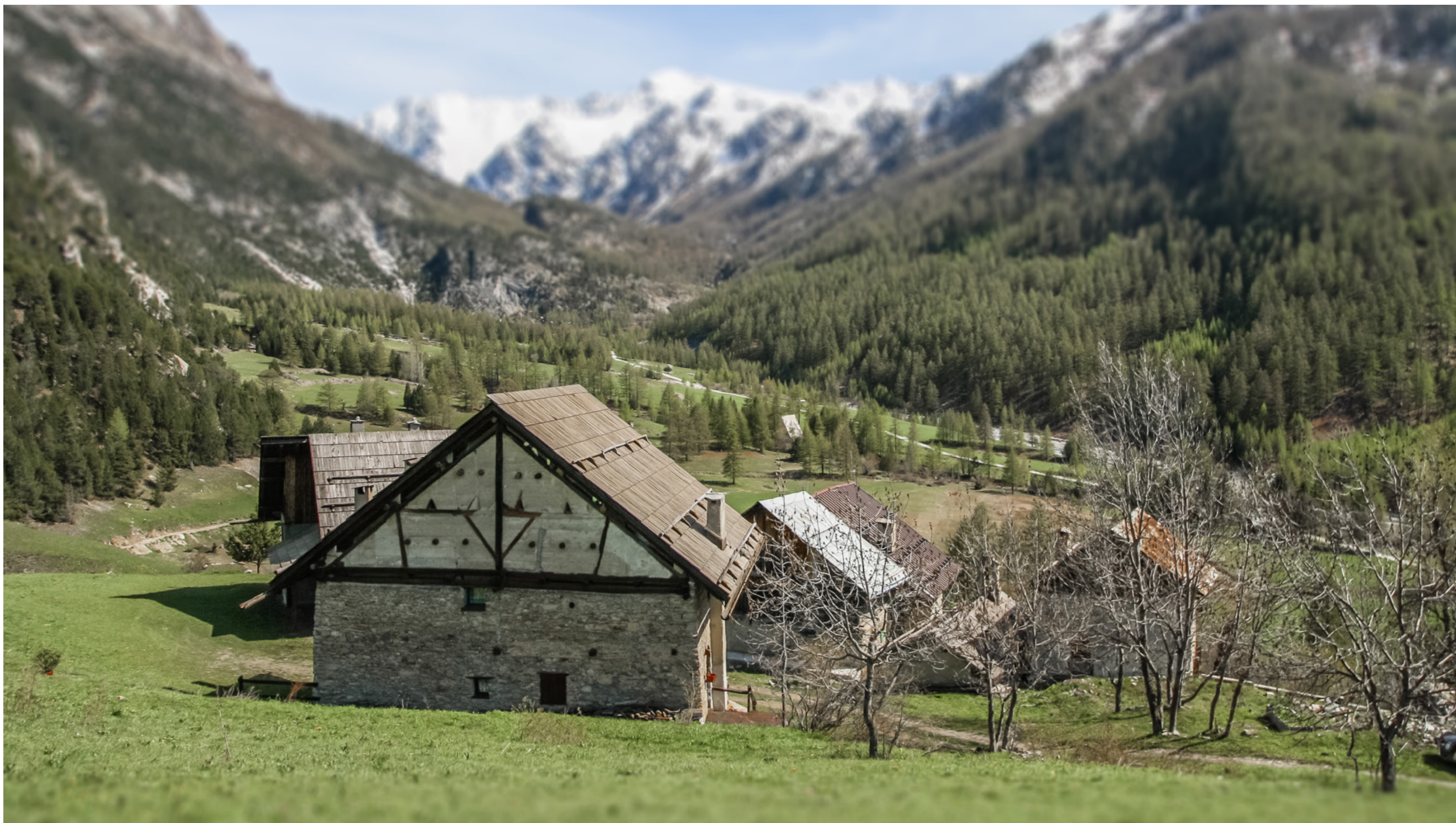
Casa C.F. - ristrutturazione - abitazione unifamiliare
