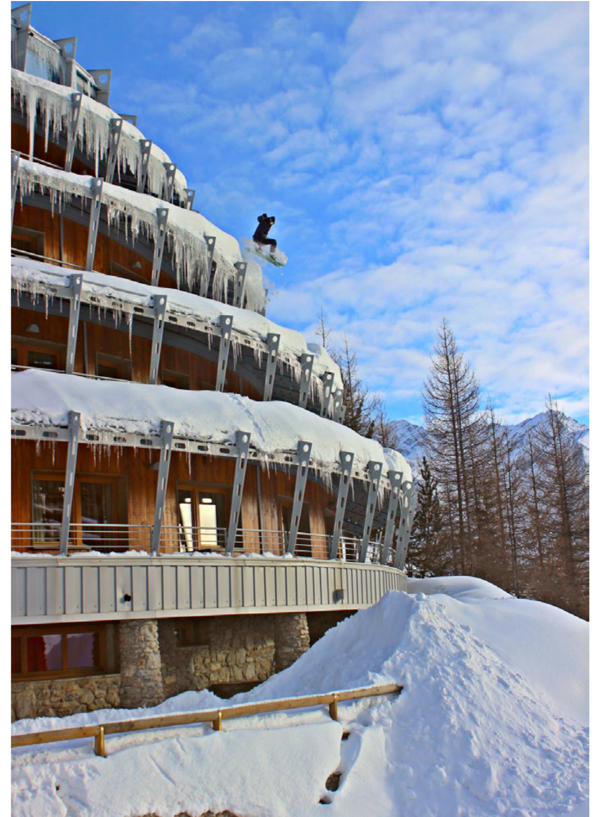
Shakleton hotel - nuova costruzione - hotel ****
