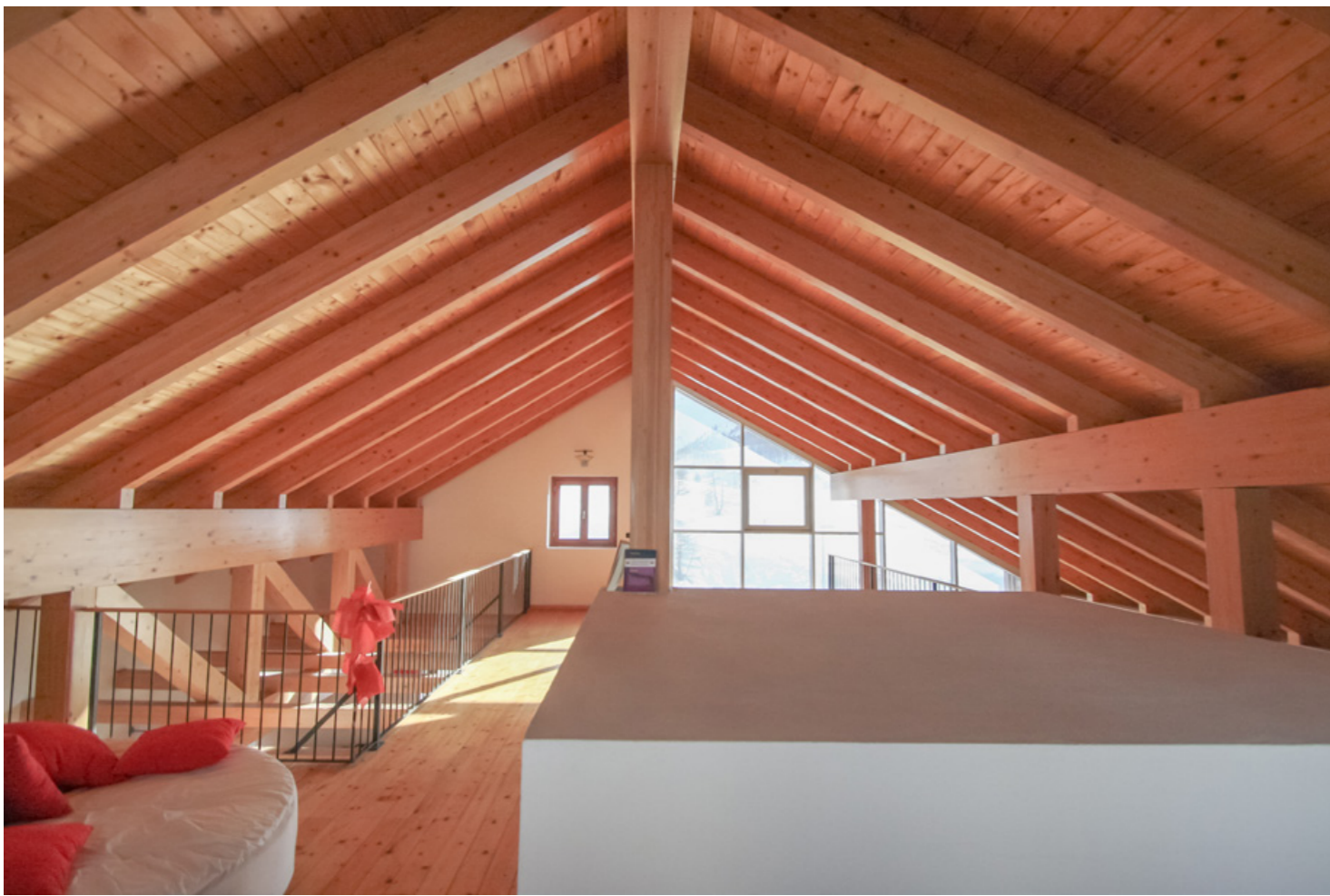
Casa Olimpia - nuova costruzione - centro culturale
