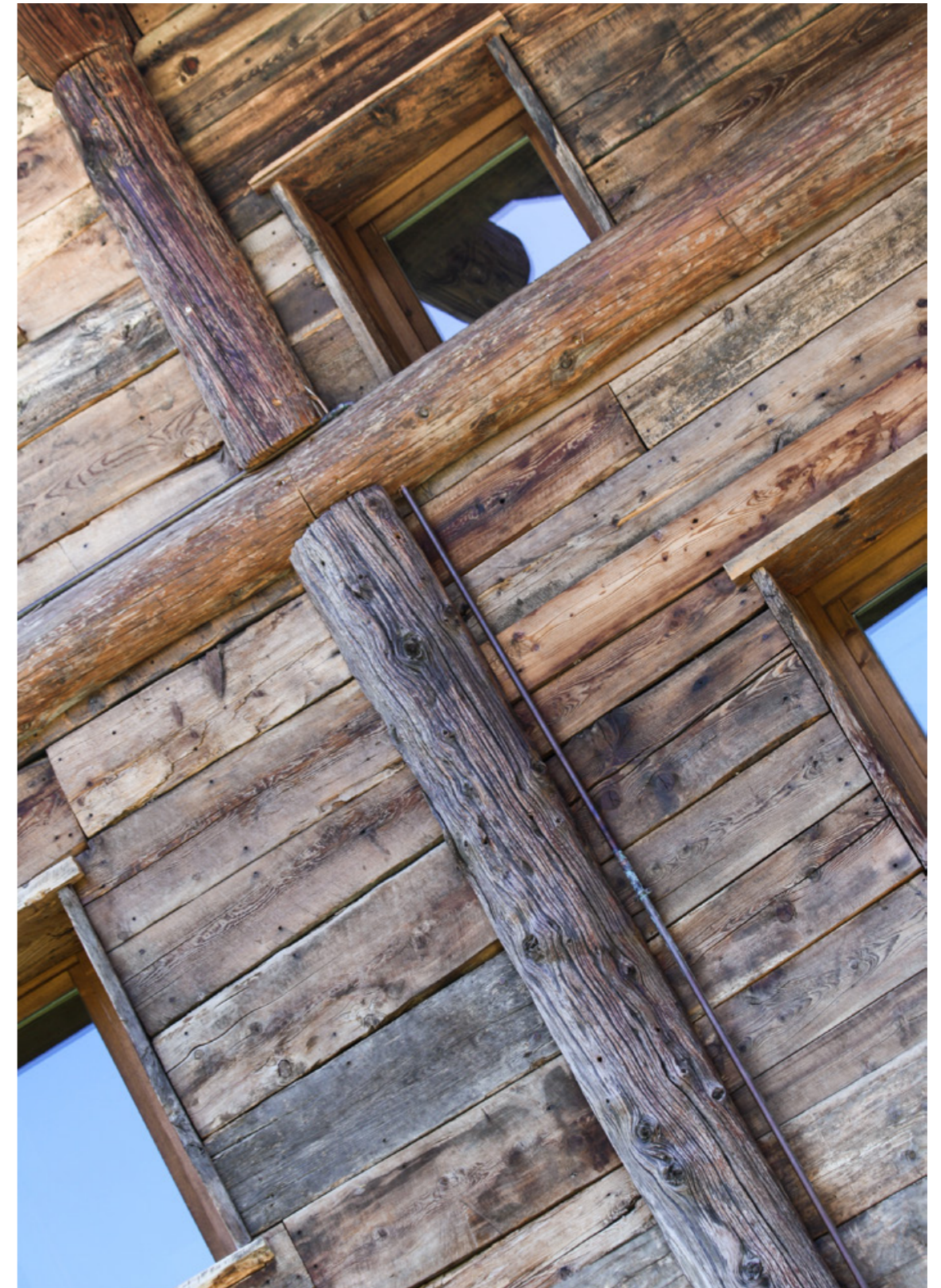
Lou Praije - ristrutturazione - abitazione plurifamiliare
