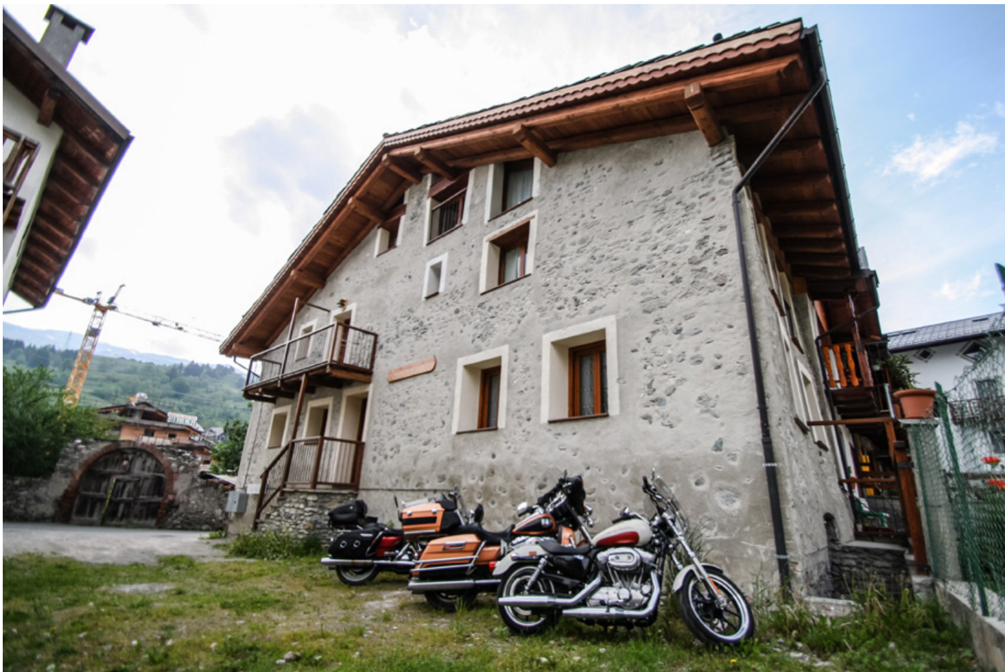
Casa del Dado - ristrutturazione - abitazione plurifamiliare
