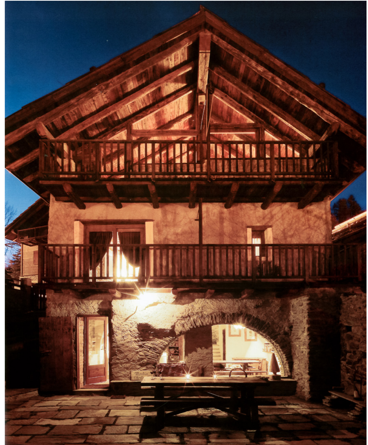
Casa V.N. - ristrutturazione - abitazione unifamiliare
