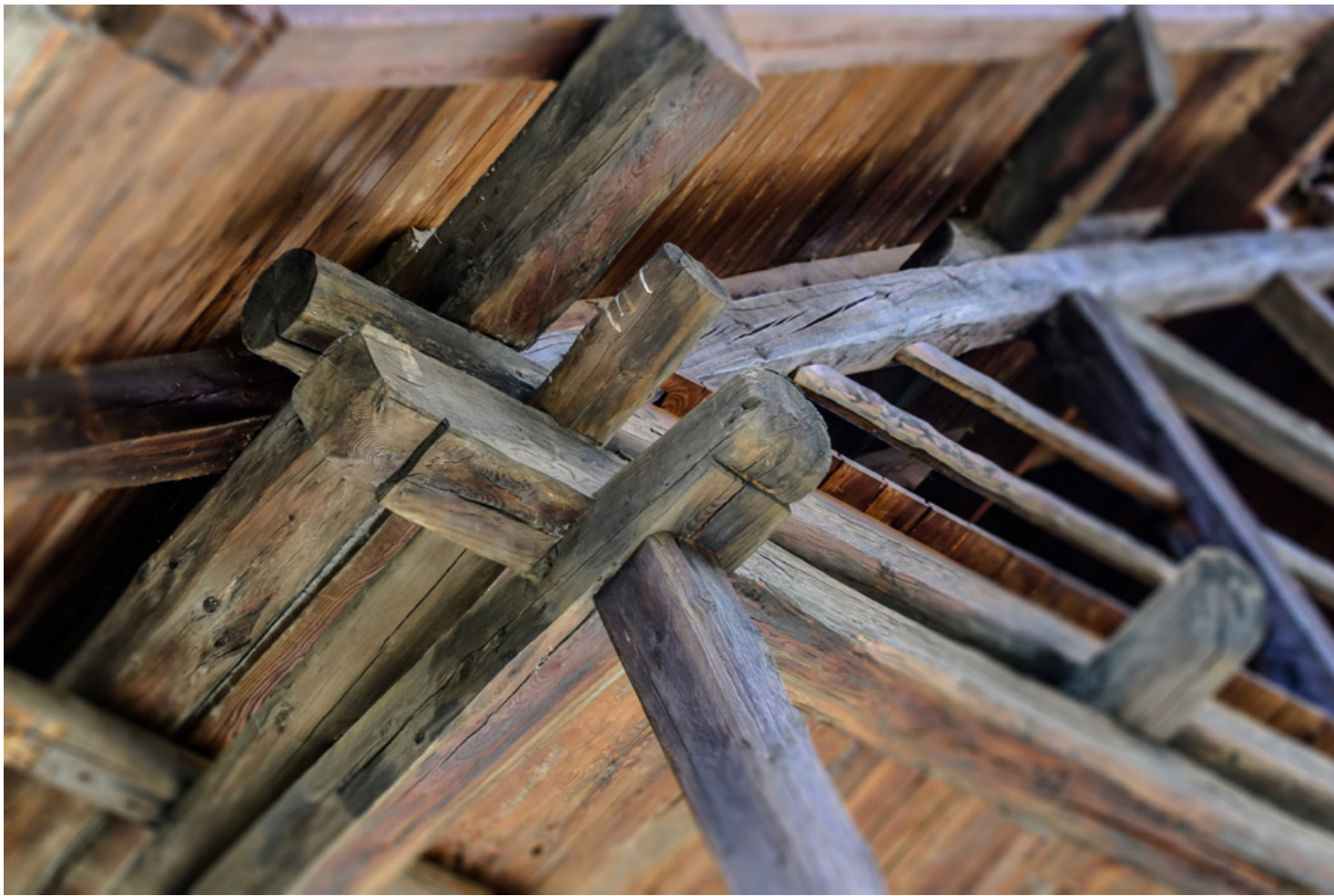
Casa C.F. - ristrutturazione - abitazione unifamiliare
