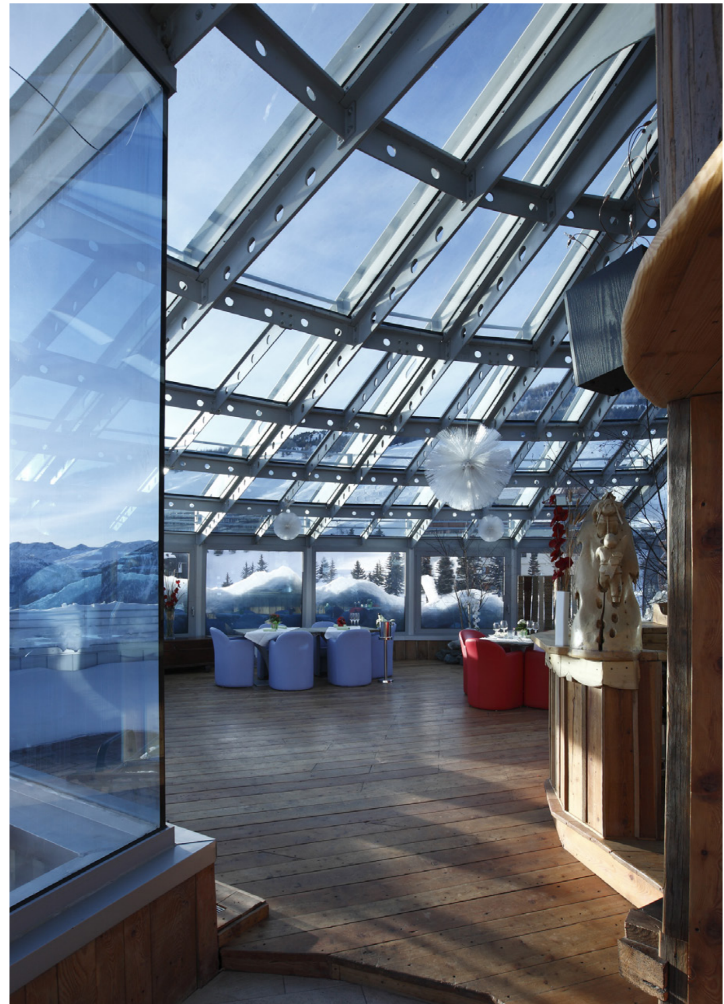
Shakleton hotel - nuova costruzione - hotel ****
