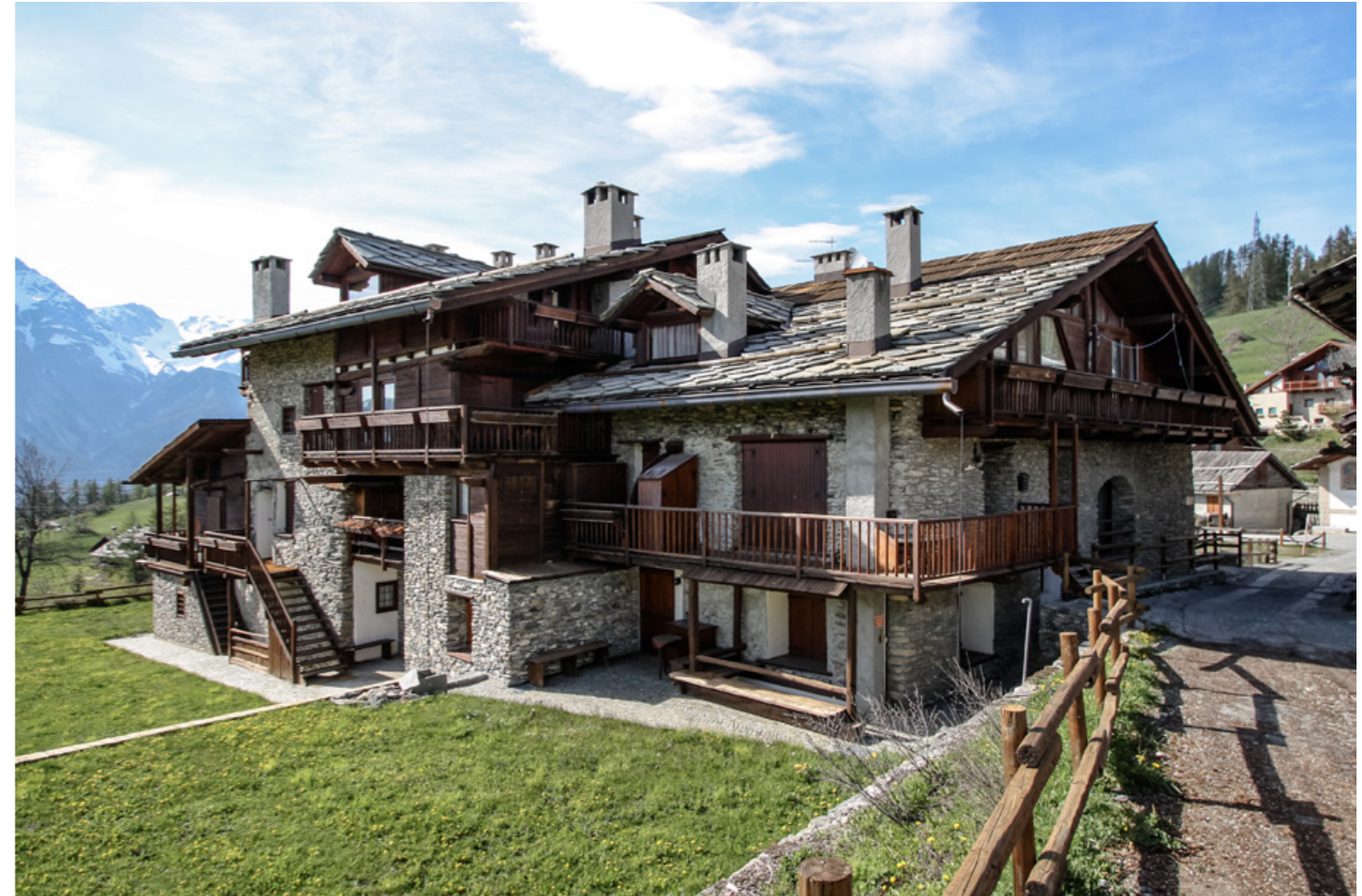
Casa Jolanda - ristrutturazione - abitazione plurifamiliare
