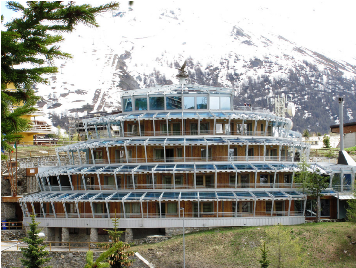
Shakleton hotel - nuova costruzione - hotel ****
