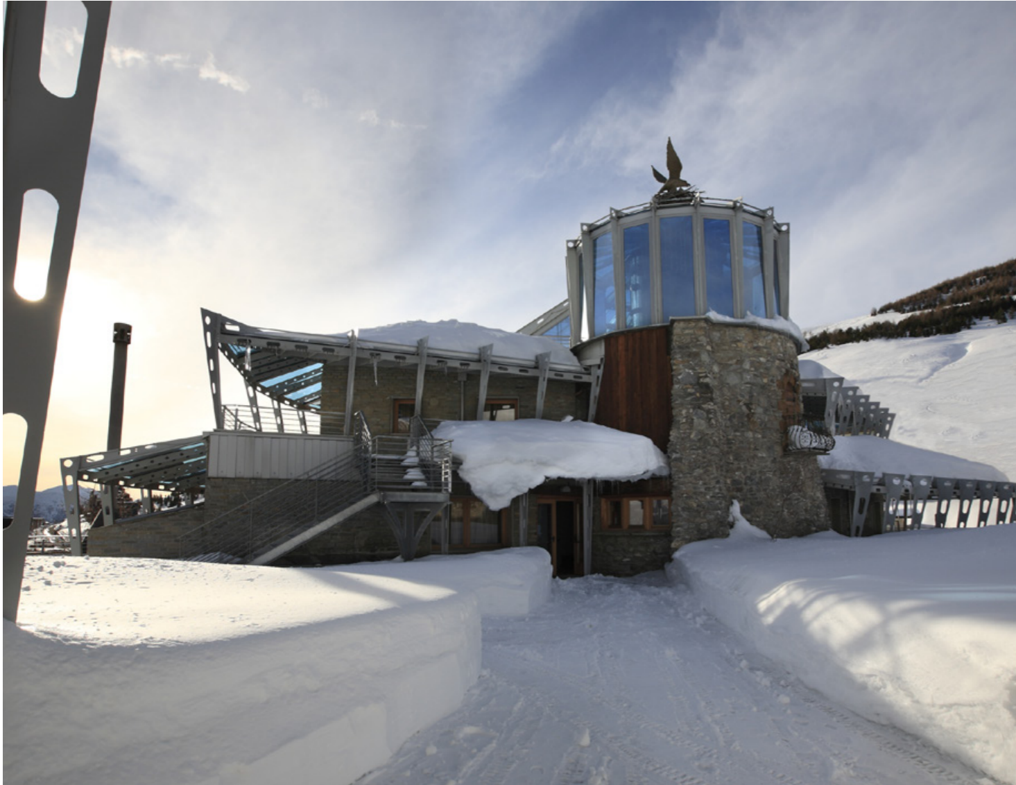
Shakleton hotel - nuova costruzione - hotel ****
