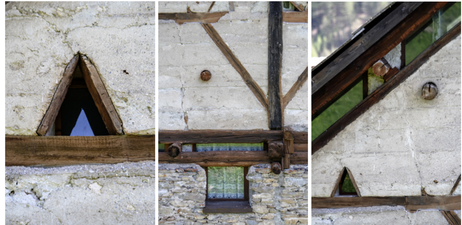
Casa C.F. - ristrutturazione - abitazione unifamiliare
