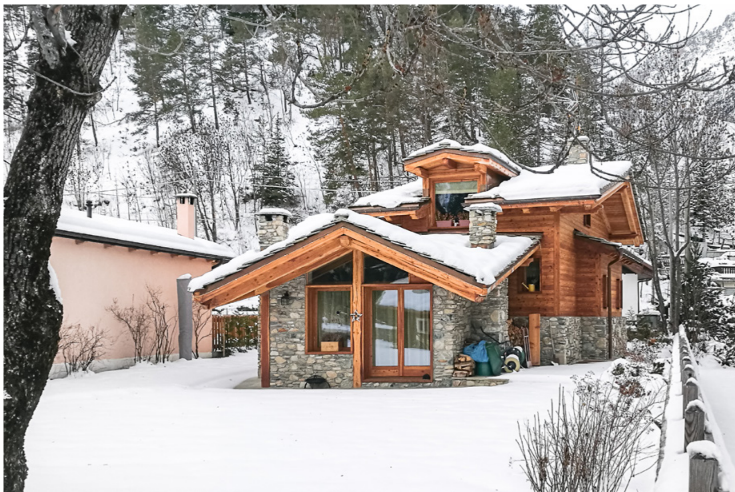
Casa G.M. - nuova costruzione - abitazione unifamiliare
