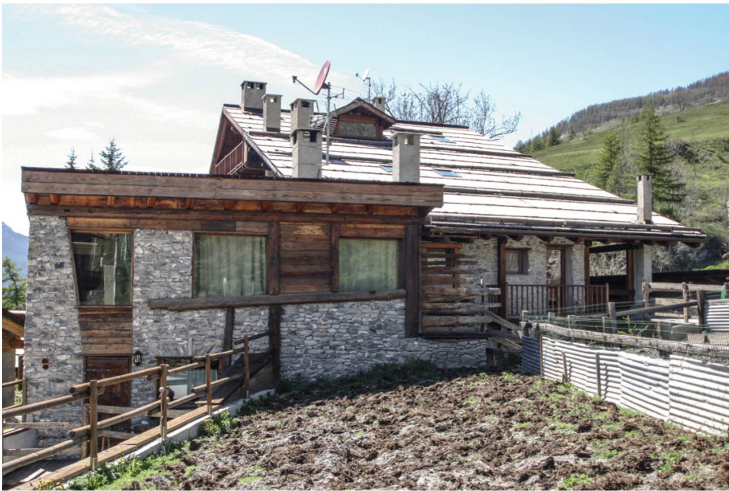
Lou Praije - ristrutturazione - abitazione plurifamiliare
